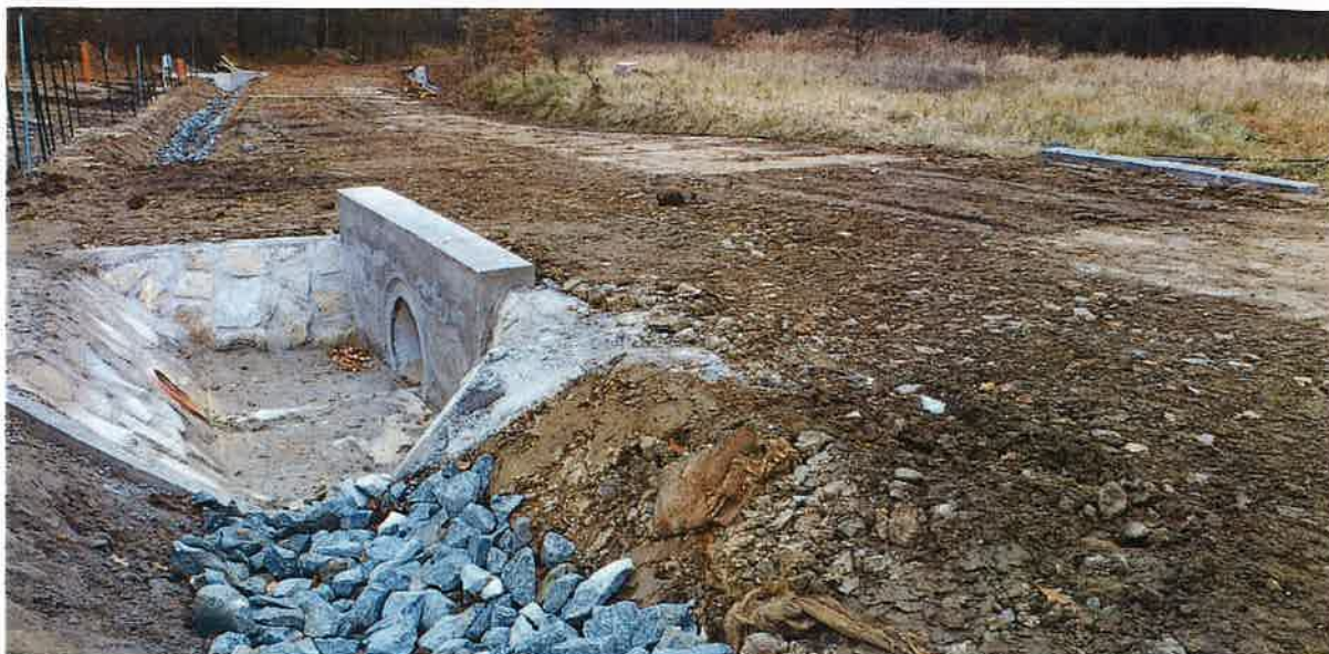
Obr. č. 2: Obnova stávajícího propustku do odtokového příkopu, obvodový příkop skládky
