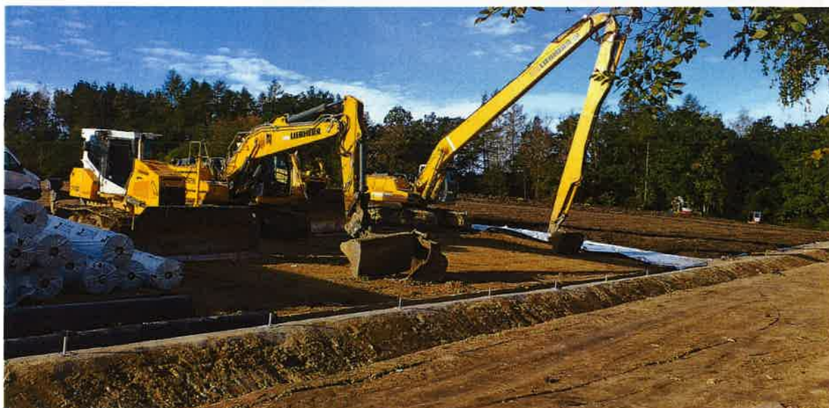
Obr. č. 3: Modelování skládky a budování těsnící vrstvy skládky
